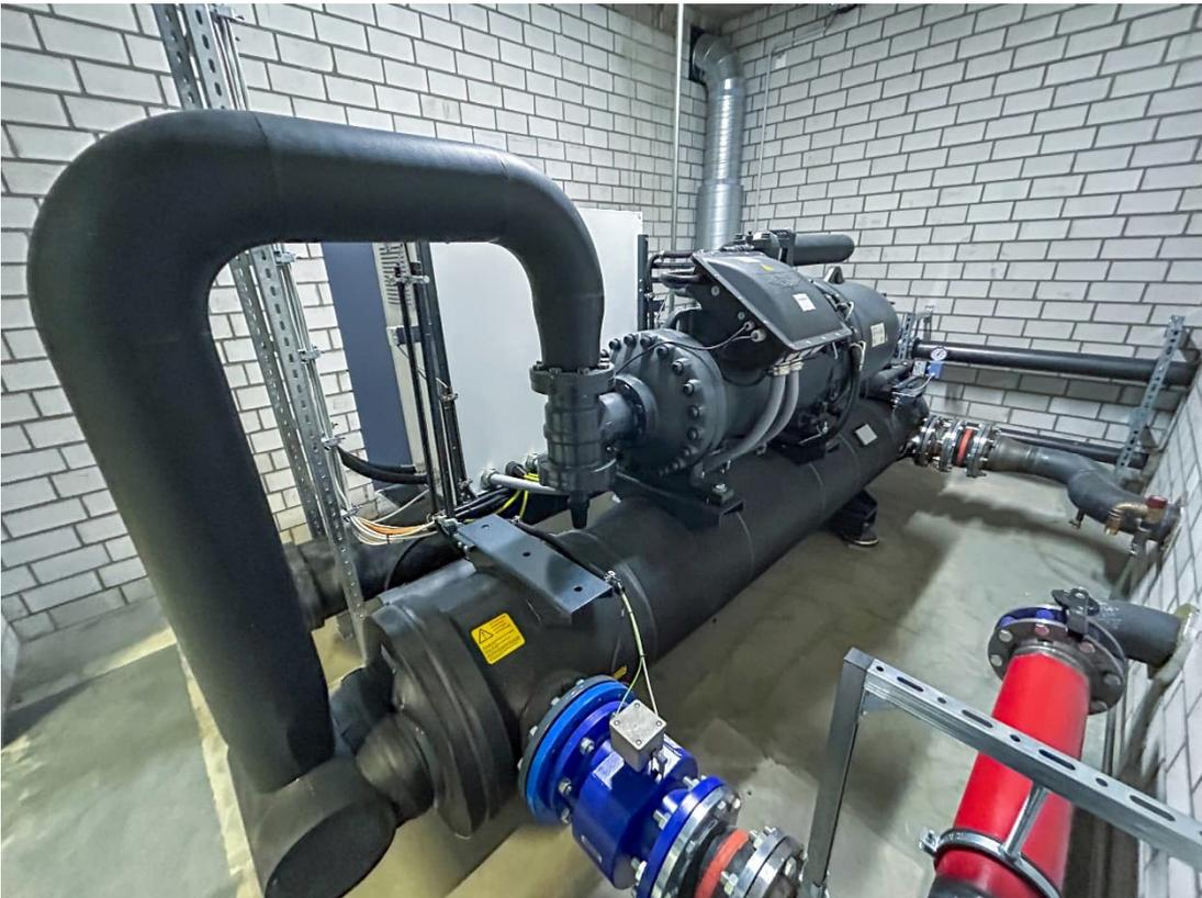
Zentrale Einheit: die neue Wärmepumpe. Mit 622kW Wärmeleistung 75-mal leistungsstärker als eine Standard-Wärmepumpe eines Einfamilienhauses.
